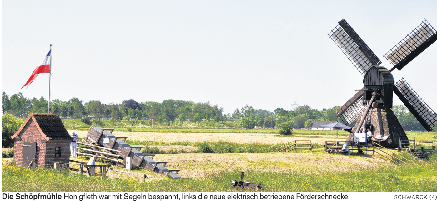
Die Schöpfungsmühle Honigfleth war mit Segeln bespannt, links die neue elektrisch betriebene Förderschnecke.
